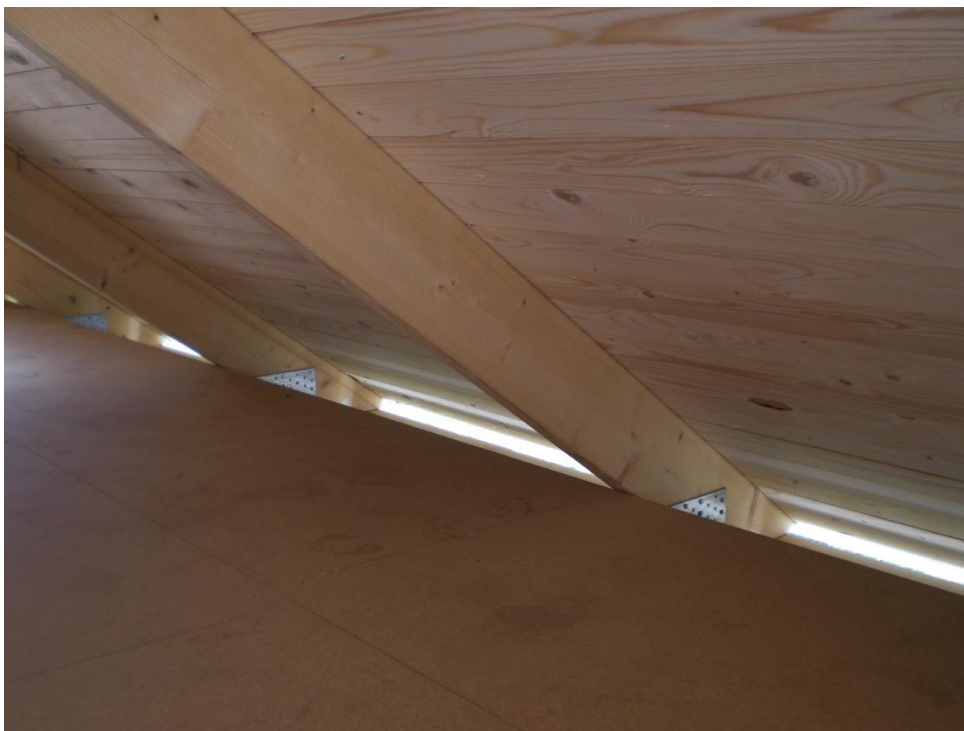
Bild 3: Vind med råspont och takstolar av trä.
