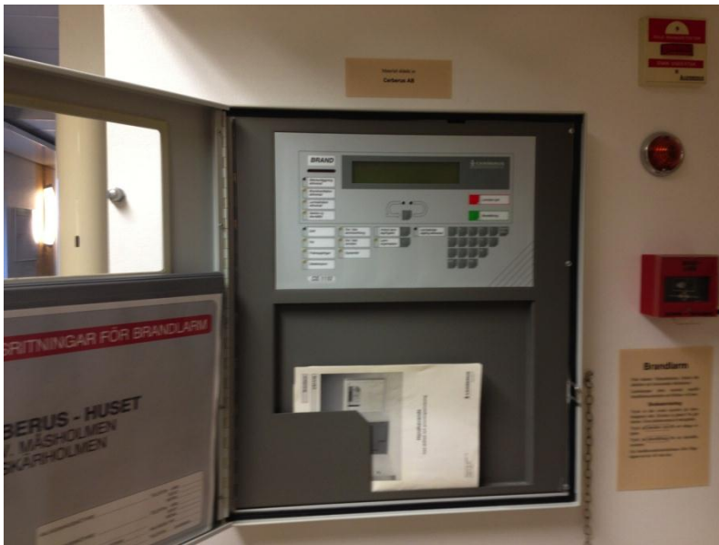
Bild 4: Centralapparat och brandförsvarstablå.
