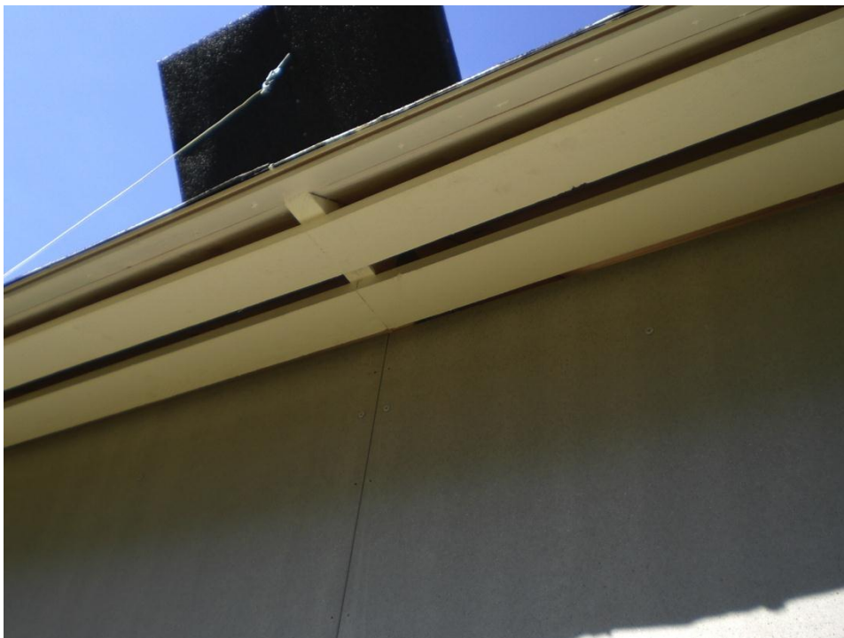
Bild 6: Glespanel i luftad takfot.
