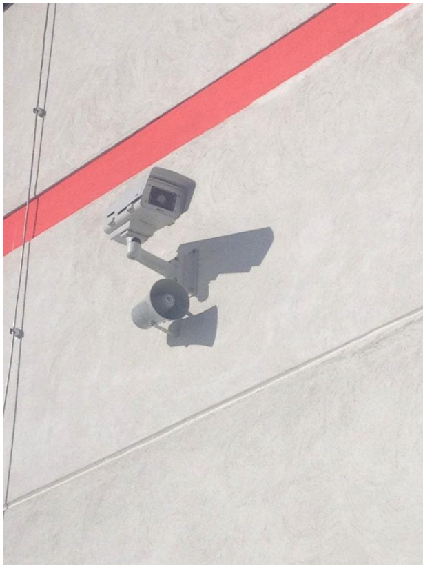
Bild 5: Termosensor med tillhörande högtalare placerad vid en skola.
