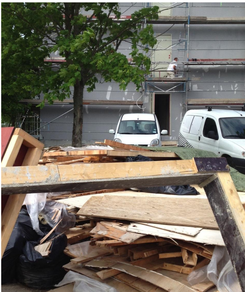
Bild 10: Under byggtiden är det viktigt att brännbart material läggs undan och ej lagras nära bygget.
